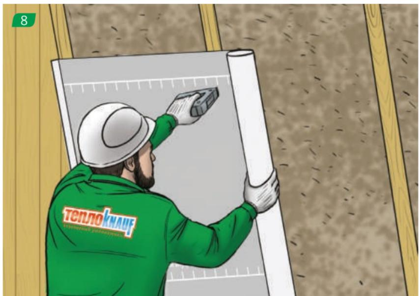
Раскатываем плёнку горизонтально вдоль нижней части стропил с заходом на стену и фиксируем степлером. Каждый последующий слой — выше предыдущего, нахлест в 10-15 см. В районе конька — также внахлест.
